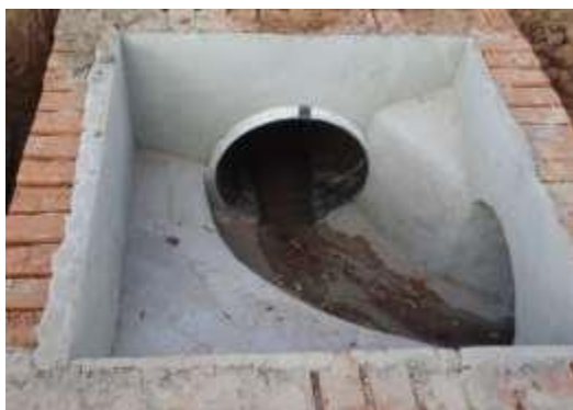
Figura 3 e 4 – Fundo das caixas de inspeção
